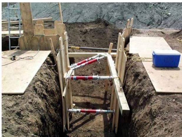
f) Las zanjas con paredes verticales en terreno suelto, con o sin sollicitación de cimentación o vial y profundidad superior a 0,80 m., se han ejecutado con entibación de madera cuajada o entibación metálica equivalente (art.11.1.c) y anexo IV, parte C, apartado 9.b).1º R.D. 1627/1997; arts. 246, 248 y 254 OLC; NTE-ADZ/1976; art.12.16 y 13.10 LISOS).
