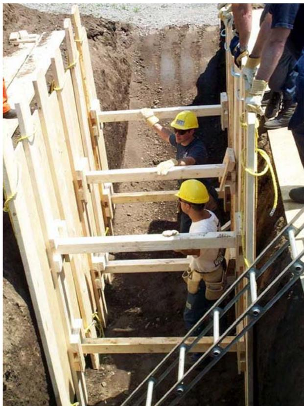
3. No debe haber maquinaria o equipos trabajando o estacionados en las **proximidades de la zanja o del vaciado** para evitar que puedan suponer una sobrecarga dinámica o estática que afecte a la estabilidad de sus paredes o que bien puedan caer al interior de las mismas de acuerdo con el artículo 11.1.c) y Anexo IV, Parte C, aptdo 9.d) RD 1627/97; NTE-ADV/1976
