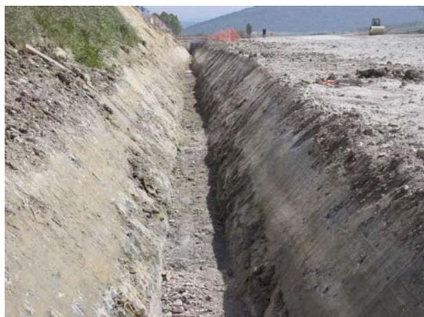
c) Los cortes ataluzados de terreno con ángulo de inclinación comprendido entre 60º y 90º (talud vertical provisional) además de no rebasar la profundidad máxima admisible según tabla 5 NTE-CCT/1977, se han ejecutado mediante bermas escalonadas con mesetas no menores de 0,65 m. y contramesetas no mayores de 1,30 m [art.11.1.c), y anexo IV, parte C, apartado 9.d) R.D. 1627/1997; arts. 246, 247 y 248 OLC; NTE-ADV/1976 y NTE-CCT/1977; art.12.16 y 13.10 LISOS].
