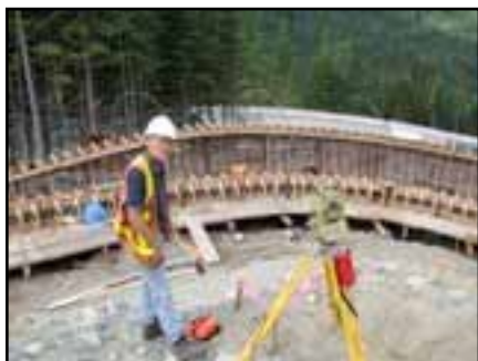
"Trabajos de topografía en la construcción de las instalaciones olímpicas, foto cedida por D. Jesús Díaz"
