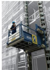
■ Uno de los ejemplos de dispositivos para el transporte de materiales de construcción entre lugares situados a distinta altura puede ser un elevador, como se muestra en la foto, instalado junto al edificio o estructura en construcción.
