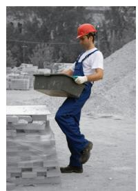
■ Cuando no se pueda evitar la manipulación manual de cargas, hay que procurar seguir las técnicas correctas de levantar y transportar, en primer lugar poner los pies correctamente junto al objeto, usar los músculos de los muslos al levantar, con la espalda derecha, y mantener el objeto que se maneja lo más cerca posible del torso.
