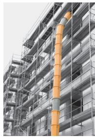
■ La manipulación de equipos adecuados como tolvas reduce la manipulación manual de cargas.
