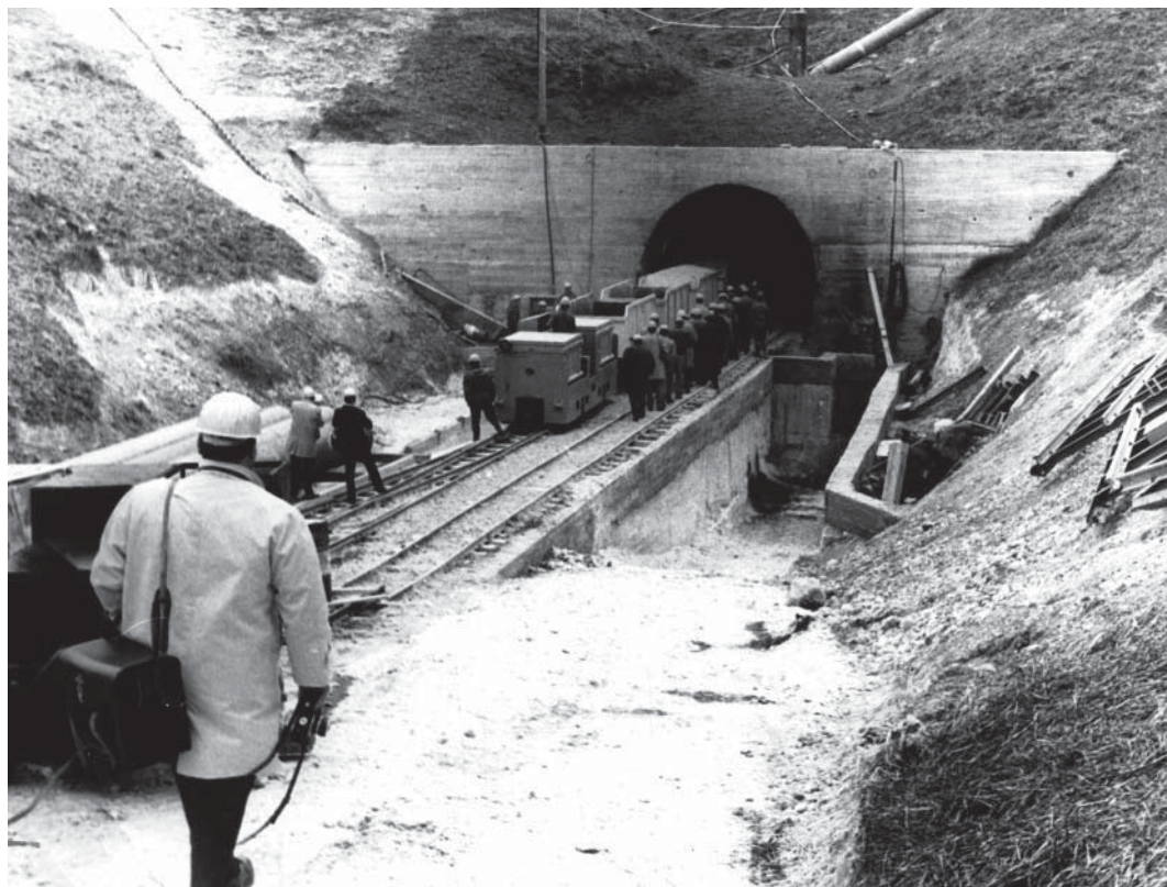
► Anónimo. Entrada a boca túnel, año 1970. Archivo SEPI.
