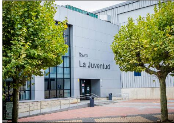
Fachada de las instalaciones deportivas de la Juventud. MARIO TEJEDOR
